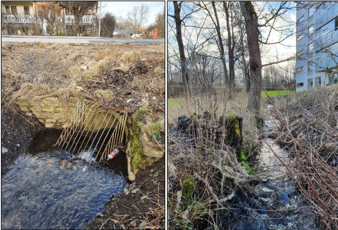
Figur 10. Dike och kulvertering inom planområdet. Foto: Norconsult
