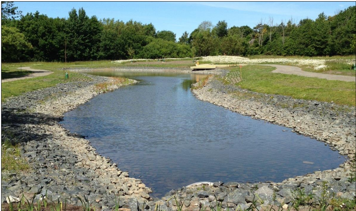
Figur 17. Exempel på dagvattendamm i Trönninge i Varberg. (Foto: Norconsult)
