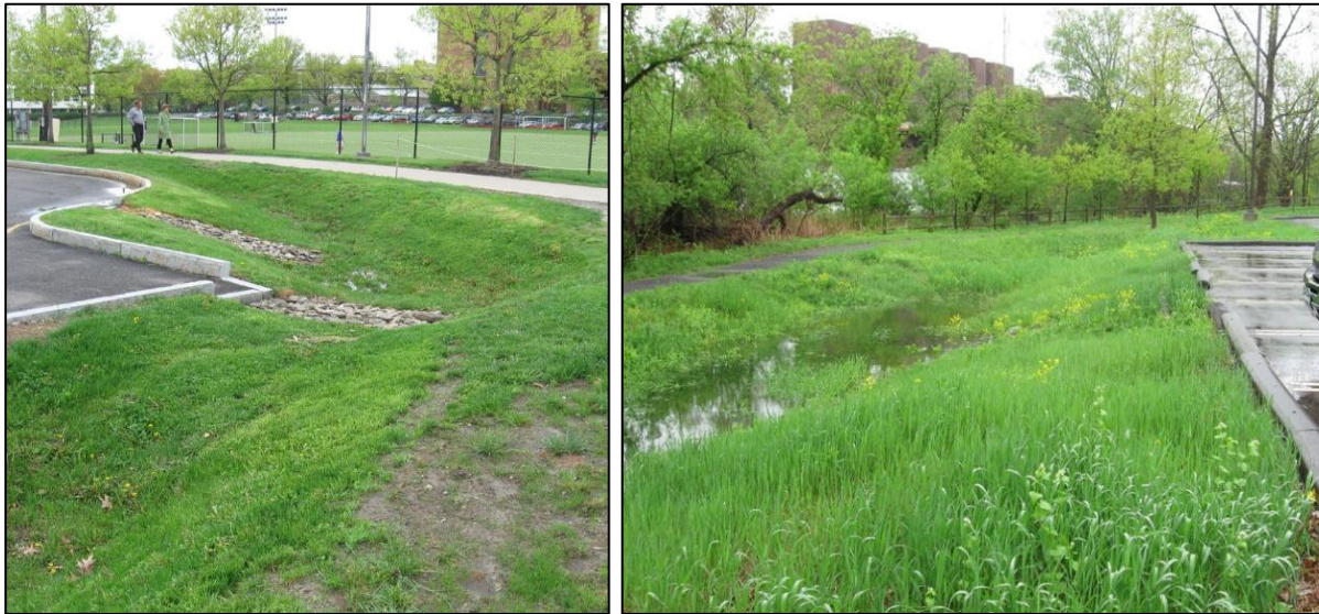
Figur 18. Exempel på torrdammar. Den högra bilden illustrerar hur en torrdamm kan se ut efter ett regntillfälle. (Foton: Lauren E. McPhillips, Penn State)
